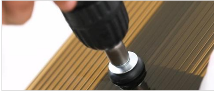
图 10 防水螺丝安装
