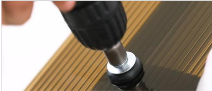
图 10 防水螺丝安装
